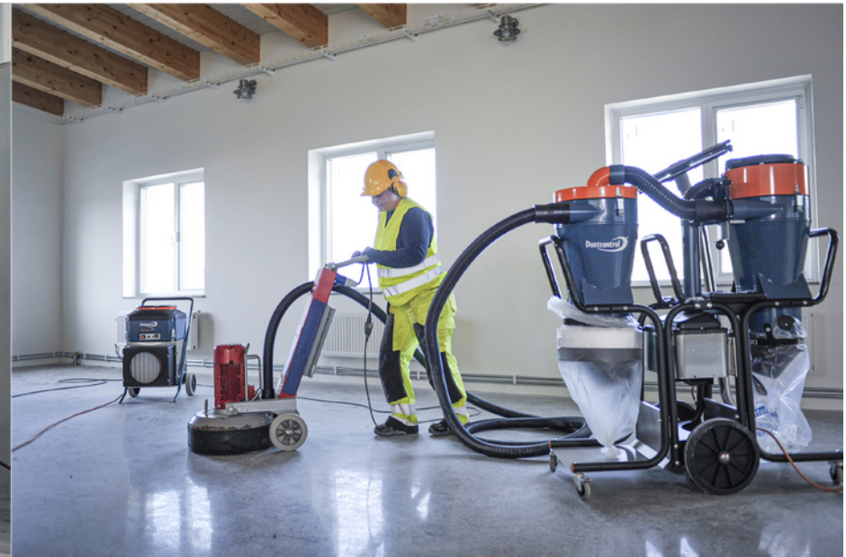
Auf dieser Baustelle wird ein einphasiger DC Tromb Twin LC zur Staubabsaugung zusammen mit einem Luftreiniger DC AirCube 1200 eingesetzt.
