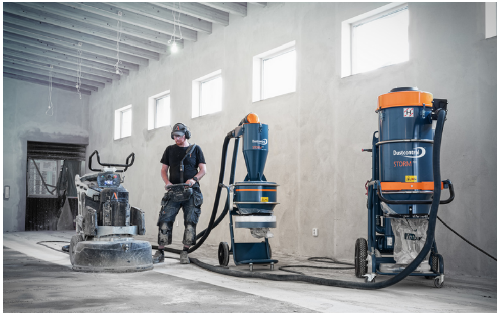
Verschiedene Optionen zum Schleifen von Betonböden mit Dustcontrol. Oben sehen Sie einen Vorabscheider DCF Storm L mit dem 3-Phasen-Entstauber DC Storm 500 C.
